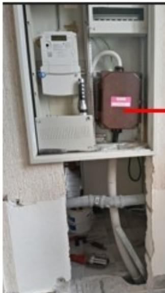
**Im ersten Schritt** wurde der Hausanschlusskasten HAK aus dem Zählerschrank in einen separaten HAK-Schrank ausgelagert.
